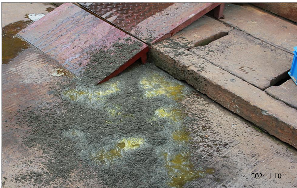
应急沙覆盖完毕
