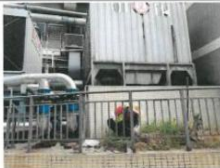
电镀污水处理站北侧
