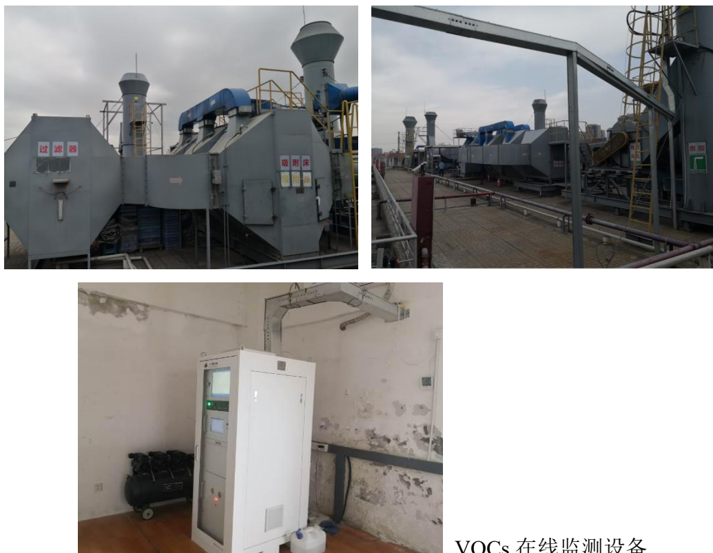
图 4.1-16 喷涂废气净化系统现状照片
