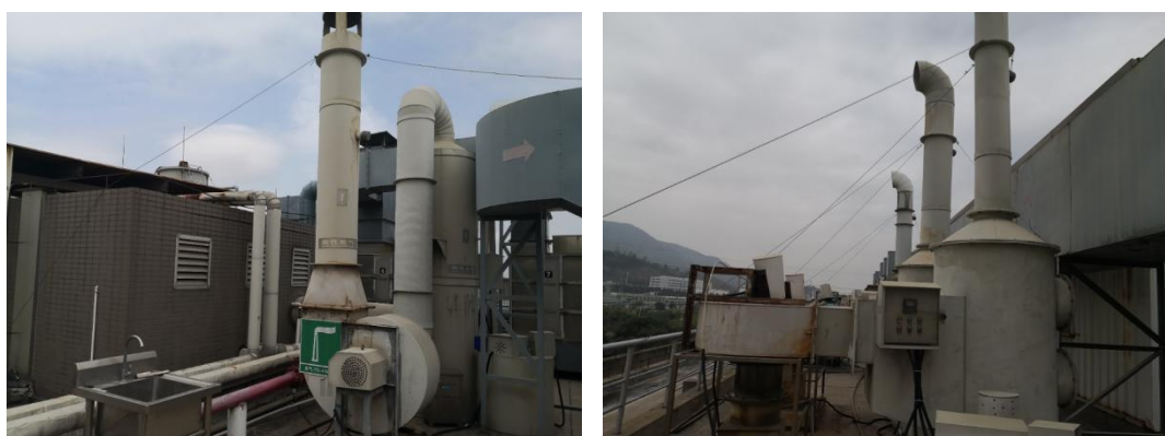
图 4.1-20 酸性废气塔现状照片
