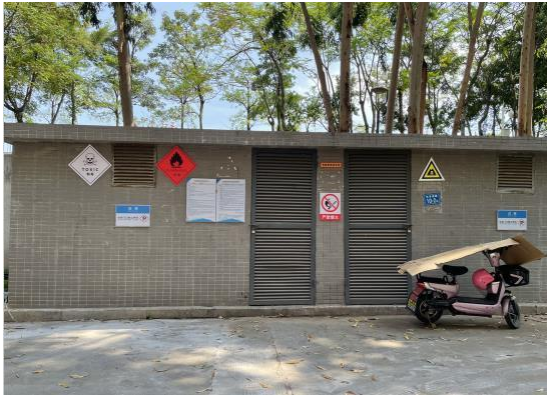
危废仓和液体危废仓
