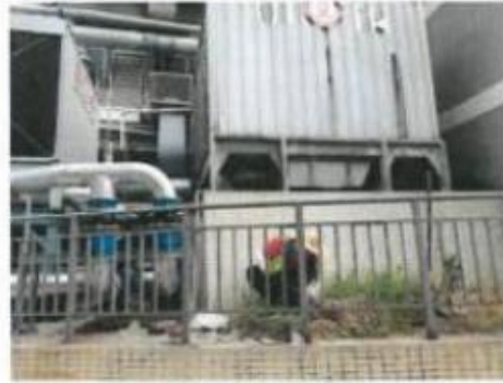
电镀污水处理站北侧
