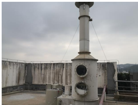
图 4.1-18 抛光粉尘处理设施现状照片
